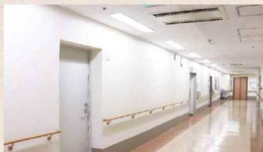
耐震壁により強固になった建物
